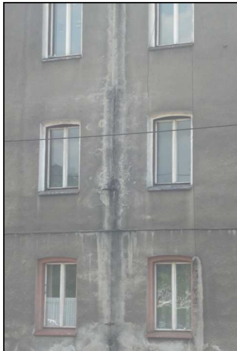
Fot. 12, Fot. 13 Budynek przy ul. Opolskiej 40. Zniszczenia tynku spowodowane zaciekiem wód deszczowych po elewacji, korozja rury spustowej.
