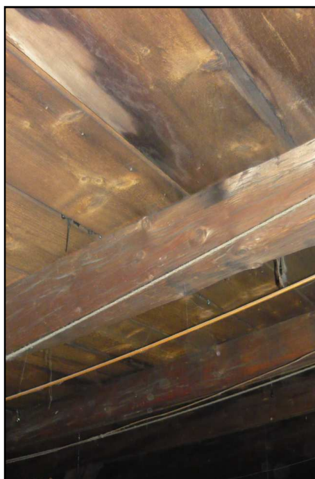
Fot. 8, Fot. 9 Budynek przy ul. Opolskiej 40. Korozja biologiczna więźby dachowej.
